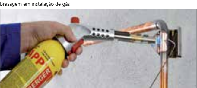
Brasagem em instalação de gás
