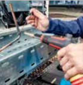
Brasagem em sistemas de refrigeração / ar condicionado
