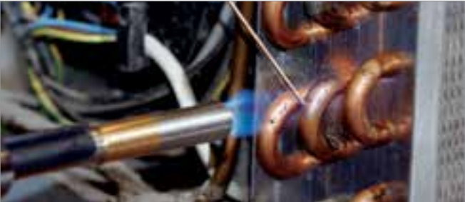
Brasagem em instalação de gás
